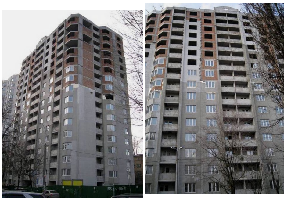
Будівництво житлового будинку по вул. Краснова, 19, Святошинський район м. Києва, станом на 05.03.2009 р.
