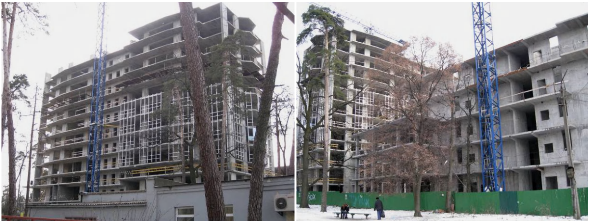
Будівництво житлового будинку по пр. Перемоги, 115-а, Святошинський район м. Києва, станом на 05.03.2009 р.
