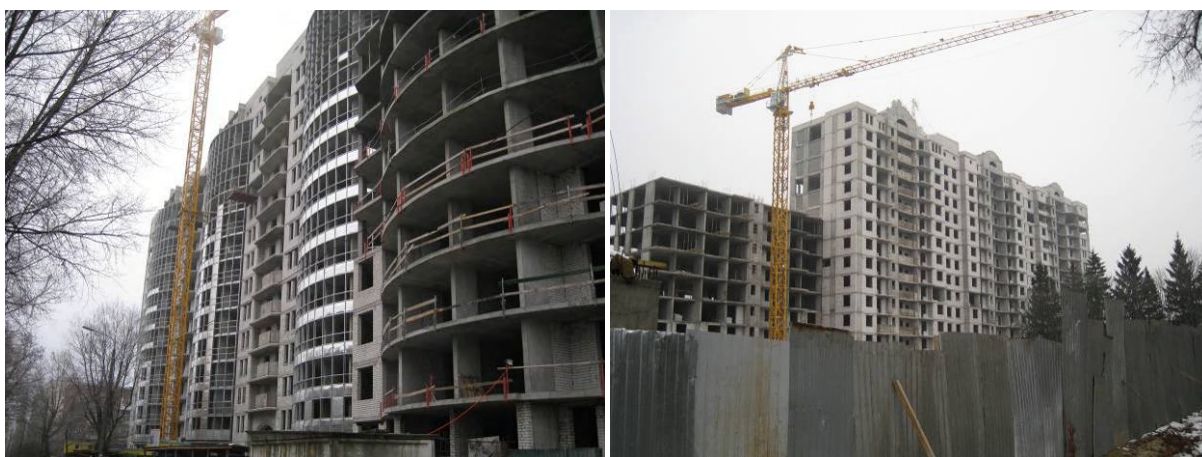
Будівництво житлового будинку по вул. Васильківській, 31/17, Голосіївський район м. Києва станом на 05.03.2009 р.
