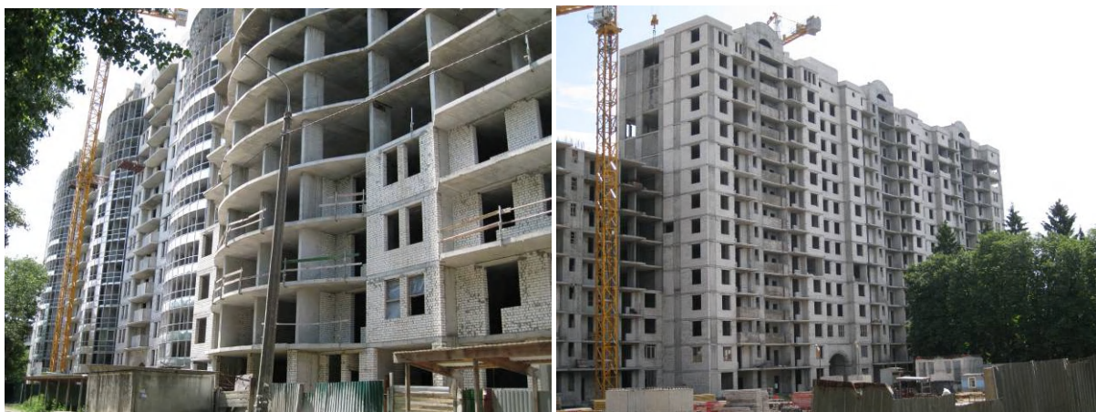
Будівництво житлового будинку по вул. Васильківській, 31/17, Голосіївський район м. Києва станом на 08.06.2009 р.
