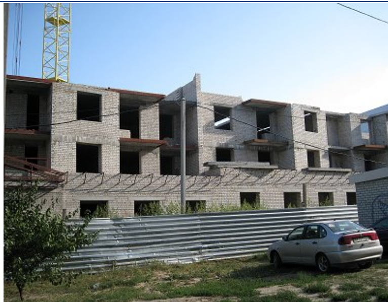
Ступінь виконання будівельних житлового будинку із вбудованими адміністративними приміщеннями по вул. Клочковській, 101 у м. Харкові станом на 21.08.2009 р.
