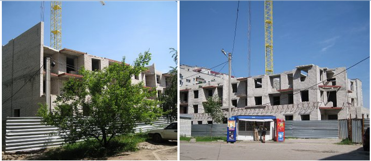
Ступінь виконання будівельних житлового будинку із вбудованими адміністративними приміщеннями по вул. Клочковській, 101 у м. Харкові станом на 22.05.2009 р.
