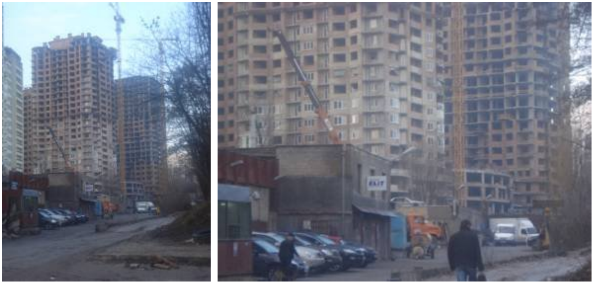
Рисунок 1.1. Будівельні роботи на об'єкті будівництва житлового комплексу по вул. Механізаторів, 2 (ж/к «Ізумрудний») у Солом'янському районі м. Києва станом на 21.11.2009 р.
