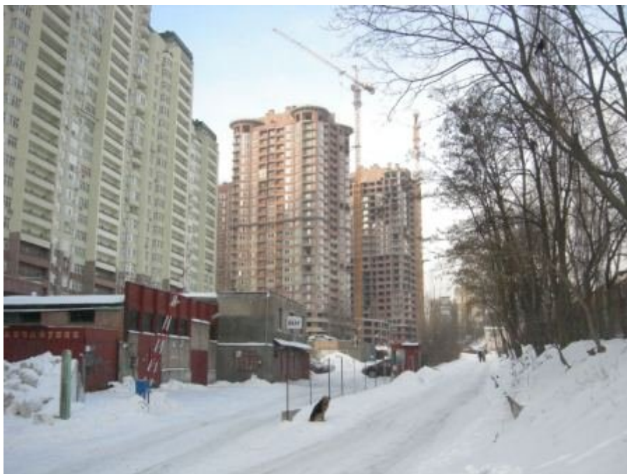
Рисунок 1.2. Будівельні роботи на об'єкті будівництва житлового комплексу по вул. Механізаторів, 2 (ж/к «Ізумрудний») у Солом'янському районі м. Києва станом на березень 2010 р.
