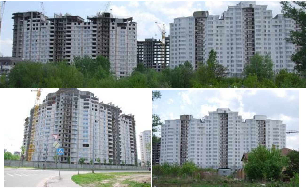
Рисунок 1. Стан будівництва житлових будинків з підземними паркінгами та закладів з обслуговування населення по вул. Вільямса,7 та вул. Ломоносова, 42-50 (III мікрорайон) у м. Києві станом на червень 2010 р.
