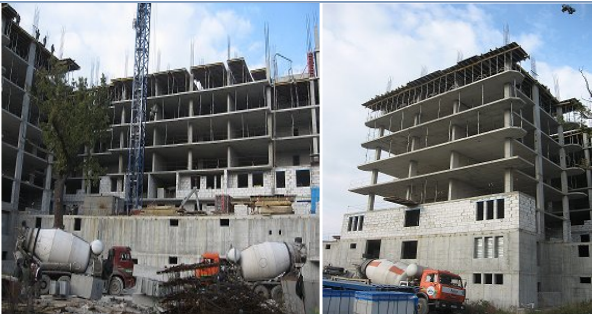
Стан будівництва житлового комплексу по вул. Фронтовій, 3 у м. Харкові станом на 15.10.2010 р.
