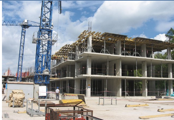
Стан будівництва житлового комплексу по вул. Фронтовій, 3 у м. Харкові станом на 20.08.2010 р.
