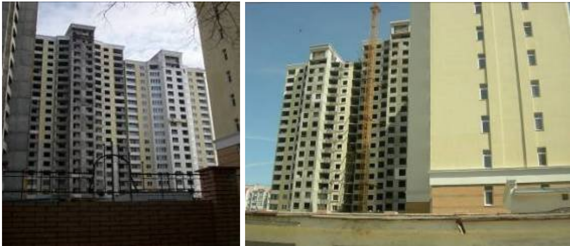
Будівництво житлового комплексу вул. Арміїській, 11 станом на 04.03.2010 р. та на кінець серпня 2010 р.
