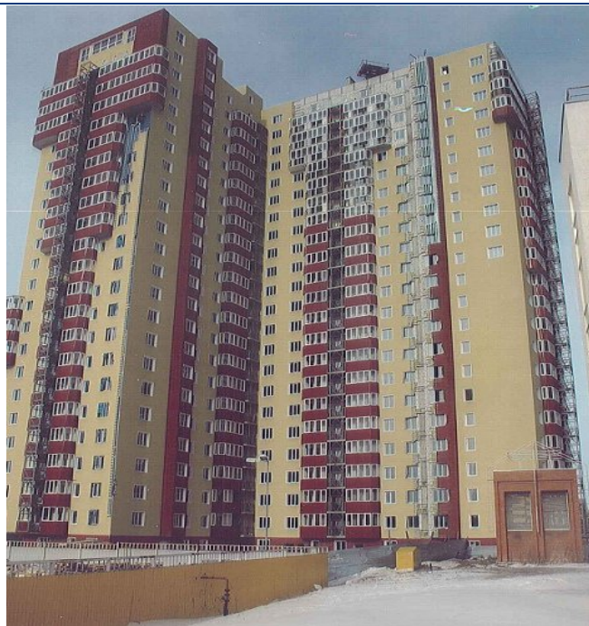
Хід робіт на об'єкті будівництва по вул. 23 Серпня (в районі буд. 31) у м. Харкові станом на кінець січня 2010 року
