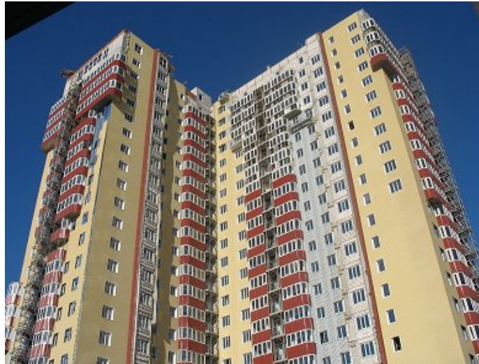
Хід робіт на об'єкті будівництва по вул. 23 Серпня (в районі буд. 31) у м. Харкові станом на 27.10.2009 р.
