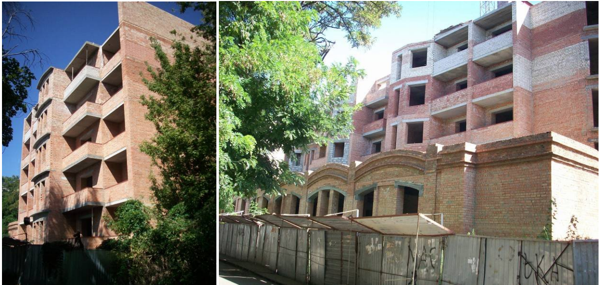
Будівництво житлового будинку по пров. Черепанових, 12. станом на 08.09.2009 р.
