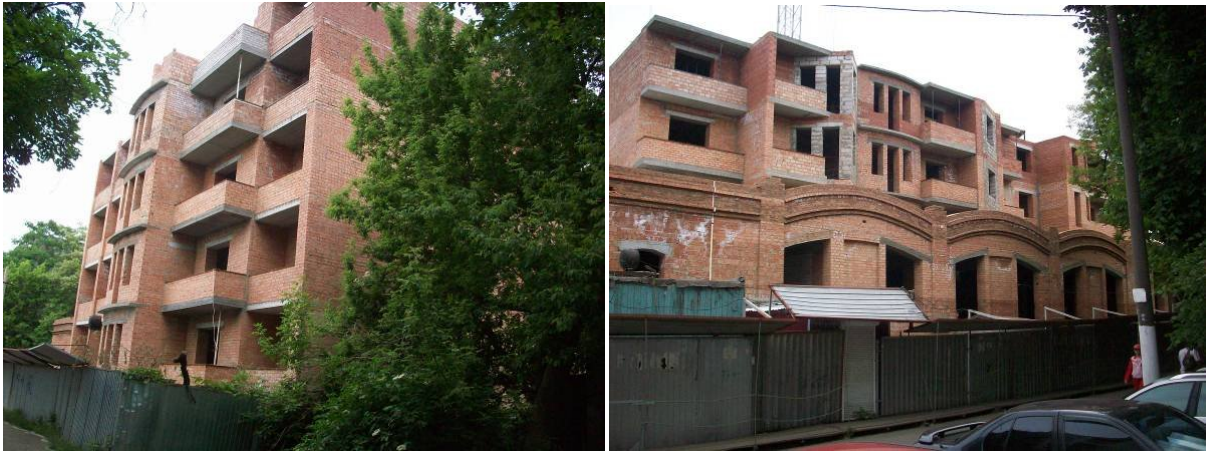
Будівництво житлового будинку по пров. Черепанових, 12. станом на 29.05.2009 р.
