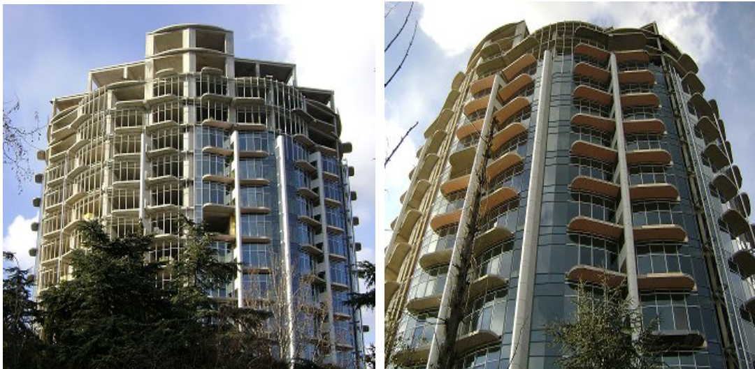
Будівництво багатоповерхового житлового будинку по вул. К. Маркса, 18а у м. Ялті станом на 09.03.2011 р.
