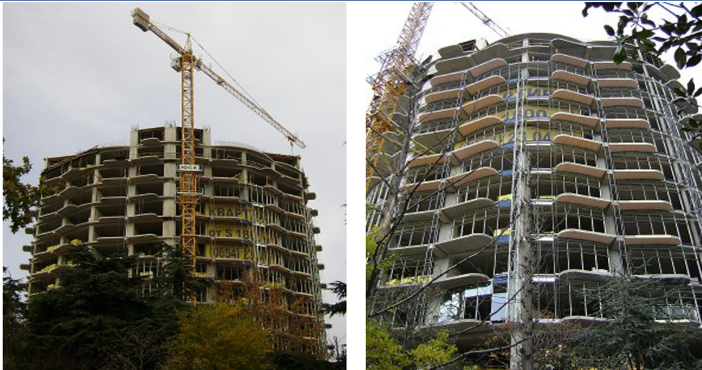
Будівництво багатоповерхового житлового будинку по вул. К. Маркса, 18а у м. Ялті станом на 11.11.2010 р
