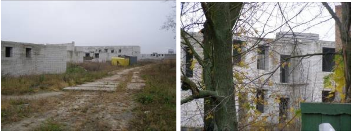
Об'єкт незавершеного будівництва - житловий комплекс з об'єктами соціально-побутової інфраструктури по вул. Леніна, 119 у с. Петропавлівська Борщагівка Києво-Святошинського району Київської області станом на листопад 2010 року
