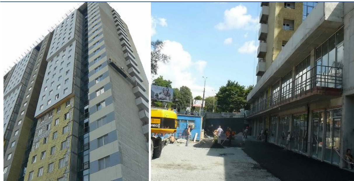
Хід робіт на об'єкті будівництва по вул. Ульянова, в районі буд. 17 А у м. Дніпропетровську станом на 10.08.2009 р.
