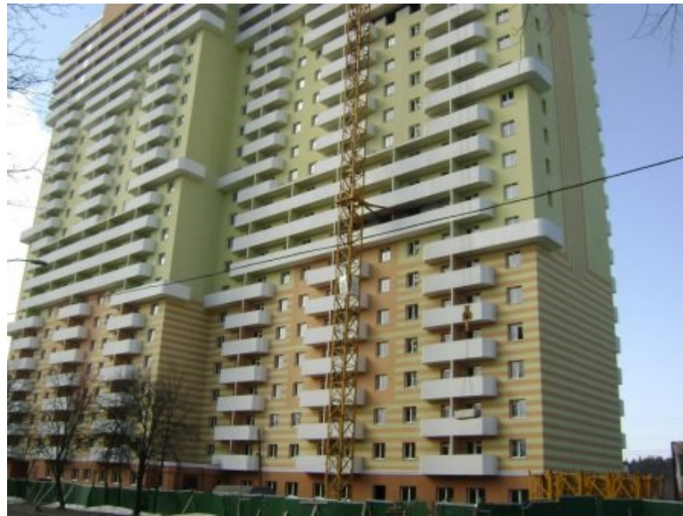
Об'єкт будівництва в м. Києві по вул. Генерала Наумова, 66
