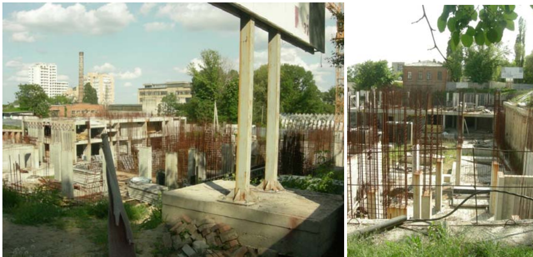
Будівництво житлового будинку по вул. Фурманова, 11 у м. Дніпропетровськ, 2010 р.
