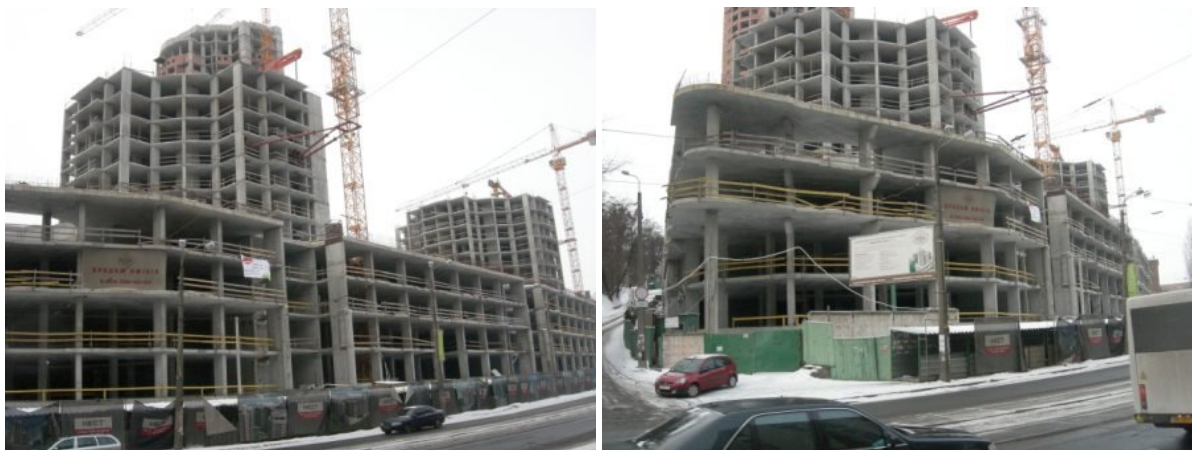
Рисунок 1. Будівельні роботи на об'єкті будівництва офісно-житлового комплексу в м. Києві на ділянці, обмеженій вулицями Глибочицькою, Студентською та Пимоненка
