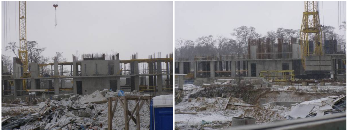
Стан будівництва житлових будинків у с. Чайці по вул. Коцюбинського, 29, 30 Київської області на 17.02.2009 р.
