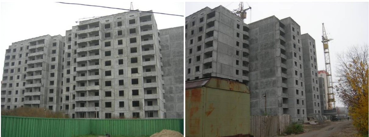
Будівництво житлового будинку по вул. Ватутіна, 97 у м. Борисполі станом на 05.11.2008 р.
