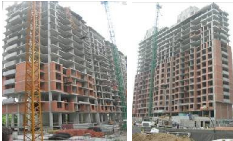
Хід робіт з будівництва ж/б 2 по вул. Професора Підвисоцького у Печерському районі м. Києва станом (зліва-направо): на 18.06.2009 р. та на 03.09.2009 р.
