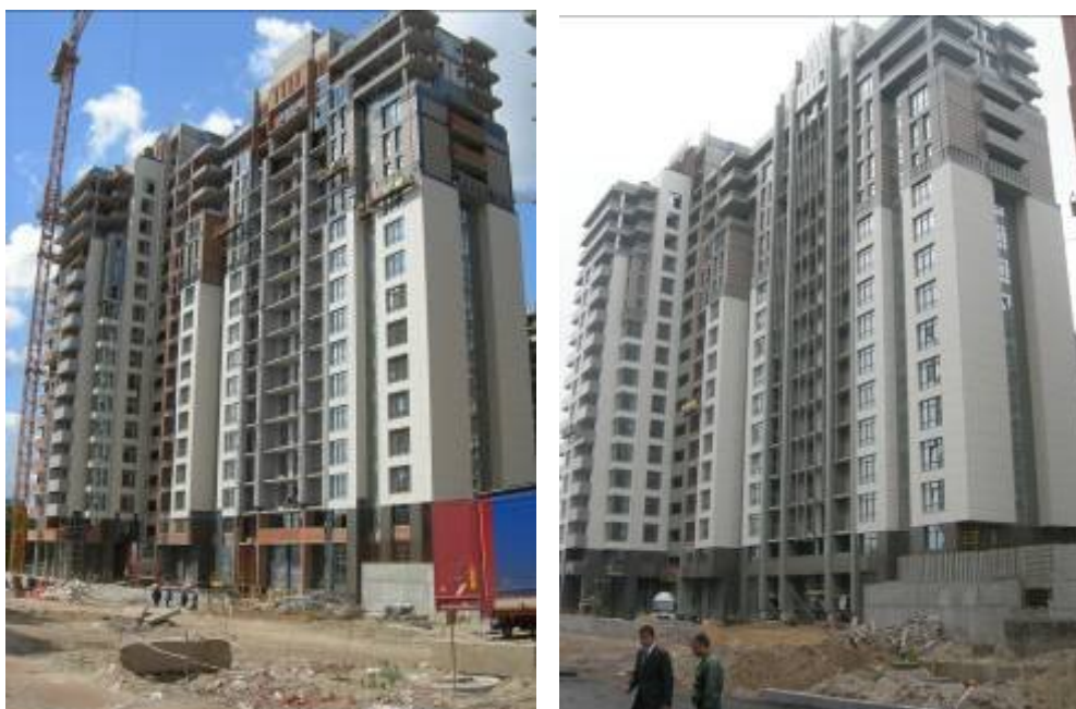
Хід робіт з будівництва ж/б 5 по вул. Професора Підвисоцького у Печерському районі м. Києва станом (зліва-направо): на 18.06.2009 р. та на 03.09.2009 р.
