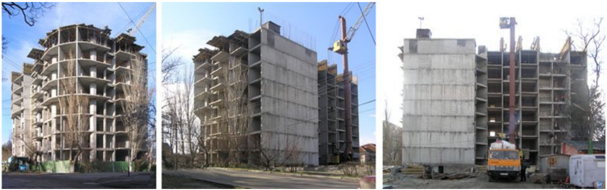
Будівельні роботи по вул. Вересаєва, 12 у м. Феодосії станом на початок січня 2009 року
