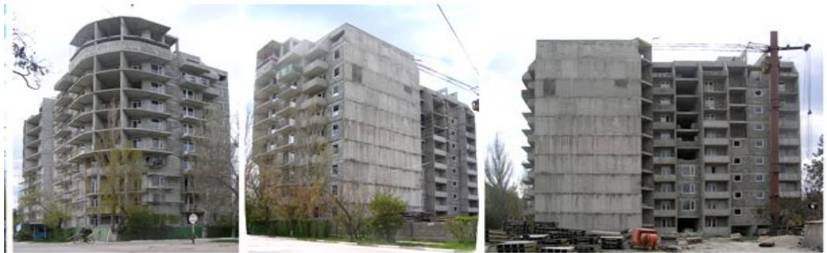
Будівельні роботи по вул. Вересаєва, 12 у м. Феодосії станом на початок квітня 2009 року
