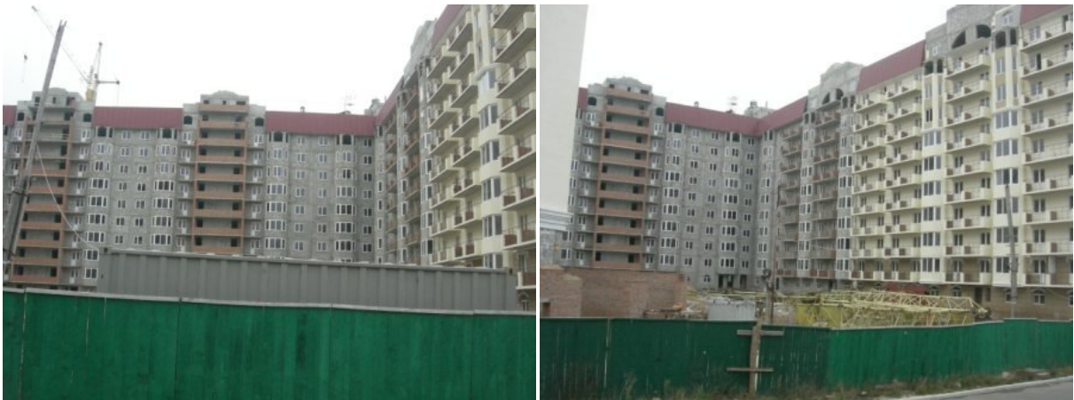
Рисунок 5. Будівництво житлового будинку у с. Чайці Київської області по вул. Коцюбинського, 9 (будівельний № 36) на початок 2010 р.
