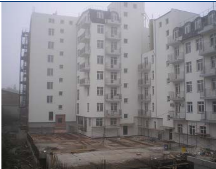
Хід будівництва групи багатоквартирних житлових будинків по вул. Червоноармійській, 43 В у м. Чернівцях станом на кінець 2010 року
