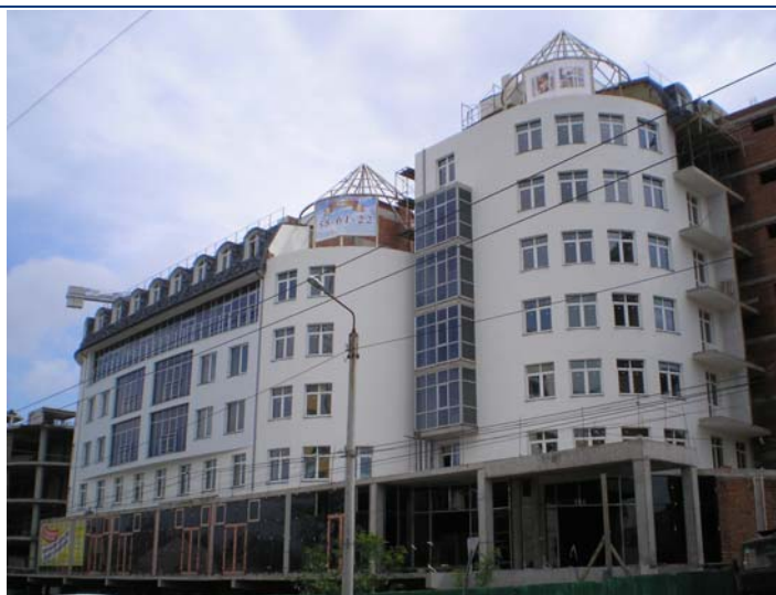
Хід будівництва групи багатоквартирних житлових будинків по вул. Червоноармійській, 43 В у м. Чернівцях станом на початок червня 2011 року
