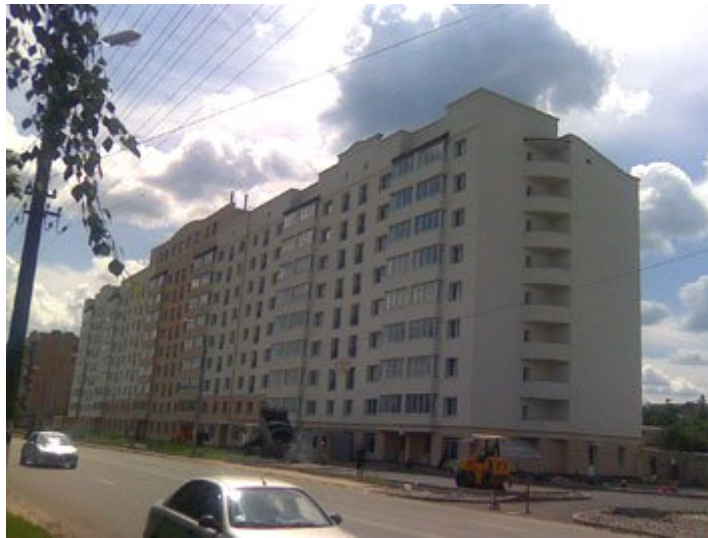
Рисунок 1. Житловий будинок по вул. Білогорській, 17-21 у м. Боярці
