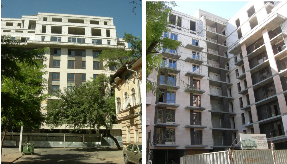
Будівництво житлового будинку по вул. Відрадній, 13 станом на кінець вересня 2010 року
