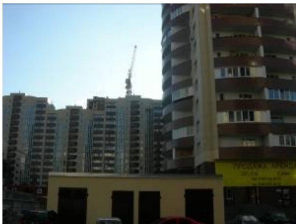
Секції 5-11 житлового будинку № 28
