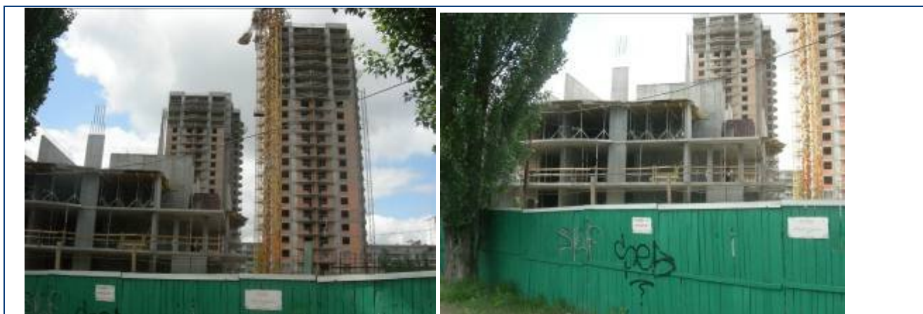
Будівельні роботи по житловим будинкам №№ 33 та 34 та № 35 станом на середину травня 2009 року
