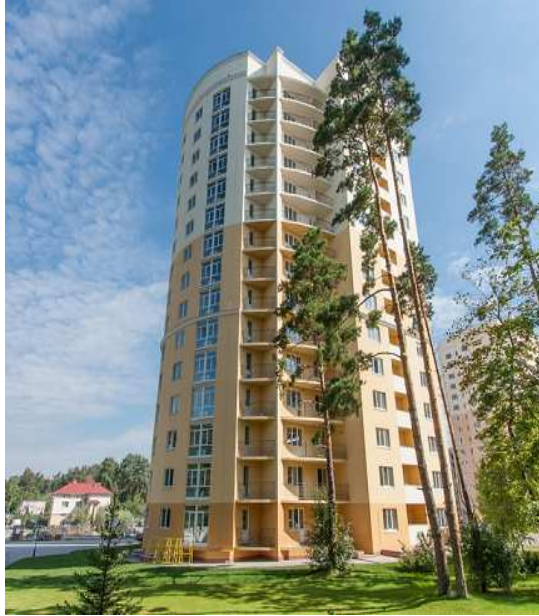
Будинок №8 (II черга) житлового комплексу по вул. Лобановського, 1 у с. Чайці Києво-Святошинського району Київської області станом на кінець серпня 2013 року
