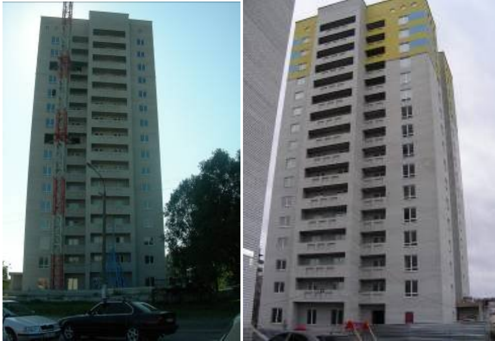
Об'єкт будівництва в районі вулиць Космічної та Мандриківської, м. Дніпропетровськ (друга черга) станом: (зліва-направо): на кінець травня 2009 року та на грудень 2009 року
