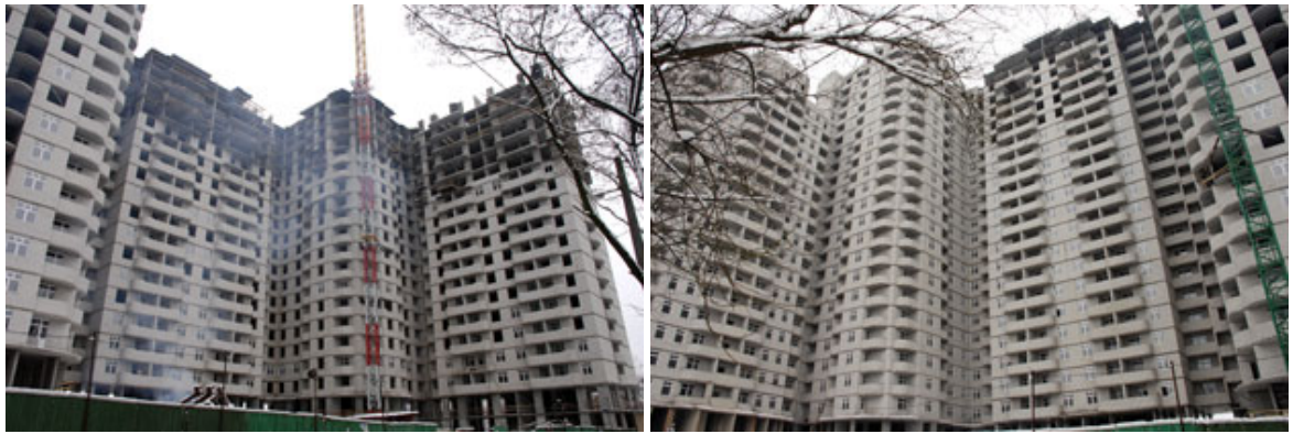
Рисунок 1.1. Будівельні роботи по вул. Майорова, 5А станом на середину лютого 2009 року
