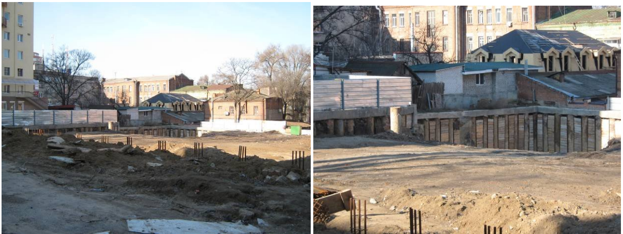
Хід робіт на об'єкті будівництва по вул. Шевченка у м. Дніпропетровську
