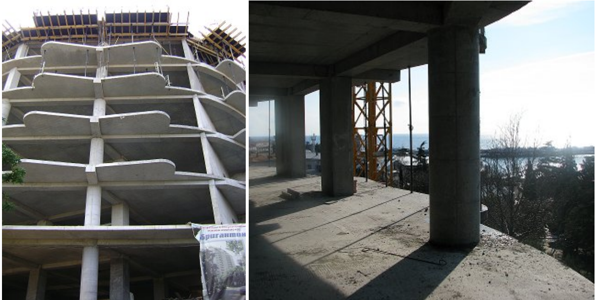
Будівництво багатопверхового житлового будинку по вул. К. Маркса, 18а у м. Ялті станом на 04.06.2009 р.
