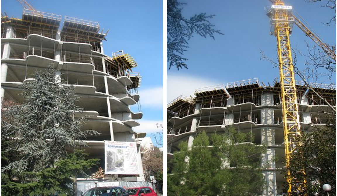
Будівництво багатопверхового житлового будинку по вул. К. Маркса, 18а у м. Ялті станом на 20.02.2009 р
