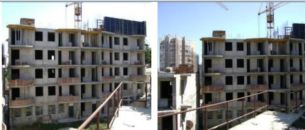
Стан будівництва житлового комплексу, який складається з житлових будинків (блок «Б1», блок «Б2», блок «Г») та підземних автостоянок (блок «А», блок «В») по вул. Жовтневій в районі житлового будинку №32 у м. Алушті станом на 21.08.2009 р.
