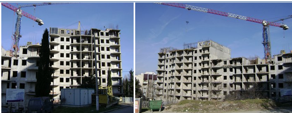
Стан будівництва житлового комплексу, який складається з житлових будинків (блок «Б1», блок «Б2», блок «Г») та підземних автостоянок (блок «А», блок «В») по вул. Жовтневій в районі житлового будинку №32 у м. Алушті станом на 09.03.2011 р.
